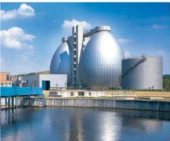
Su / Atık su istasyonu
